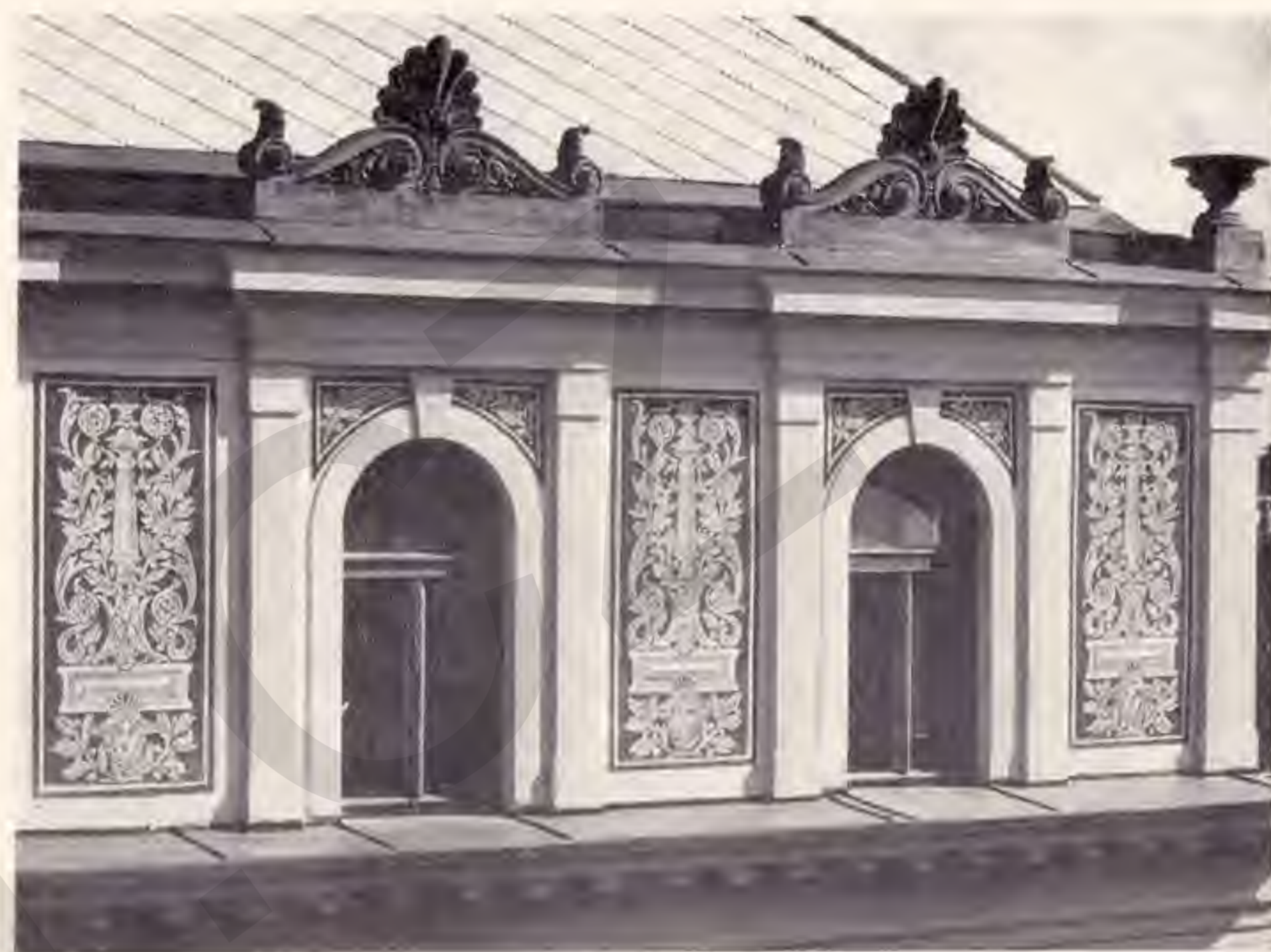
Opravená sgrafita na budově polikliniky II, Husova tř.
