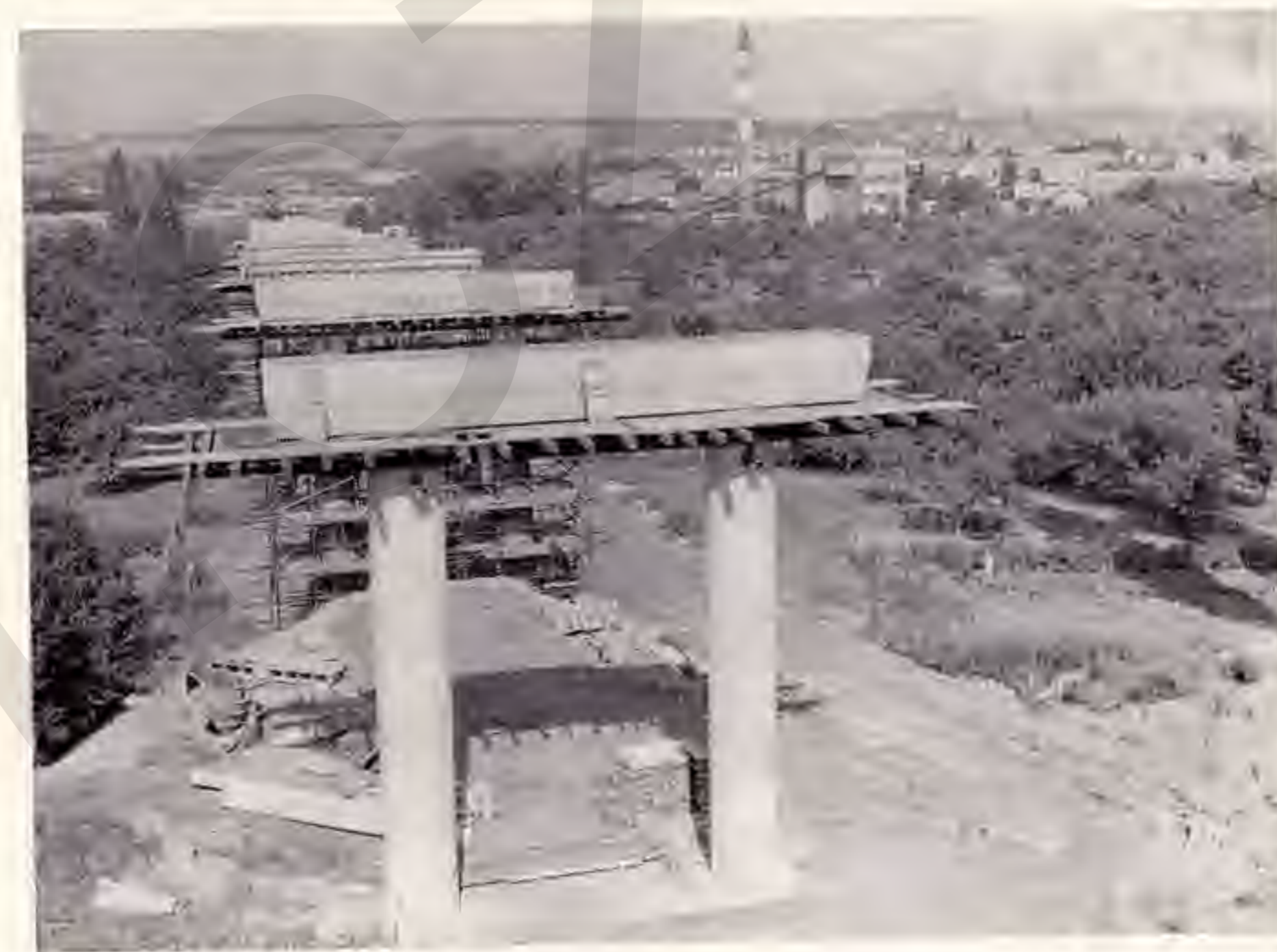
Nový pohled na Hořice umožní i mostovka přeložky.
